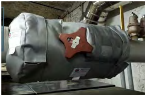
Iris et tricône sur vanne TA
