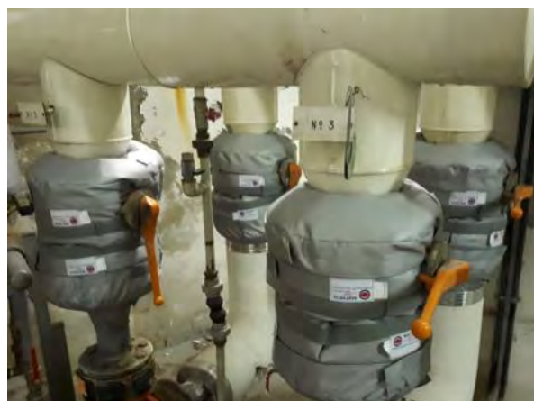
Iris avec Tricônes sur vanne papillon
