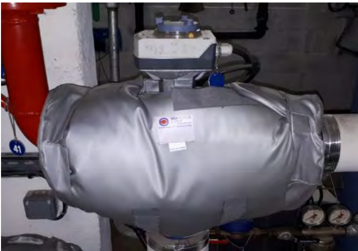
Iris et tricones sur vanne 3 Voies
